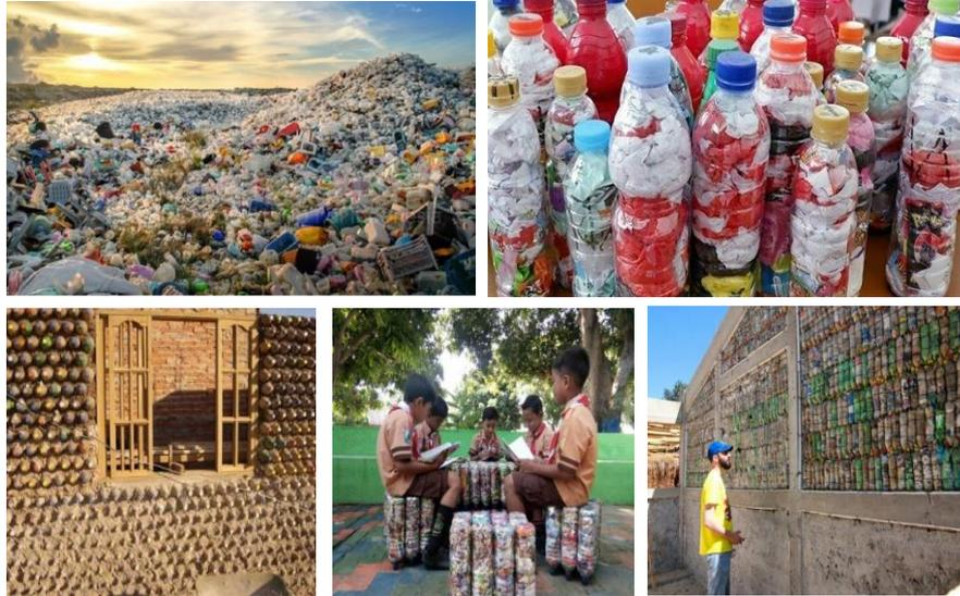
*Ecobrick* merupakan salah satu metode untuk meminimalisir sampah dengan media botol plastik yang diisi dengan sampah plastik hingga padat. Dengan menggunakan 1 botol plastik ukuran 600 ml dapat diisi sekitar 250 gram sampah plastik atau sama dengan 2500 plastik bungkus mie instan. Dengan *ecobrick* sampah plastik tidak perlu dibuang atau dibakar.
